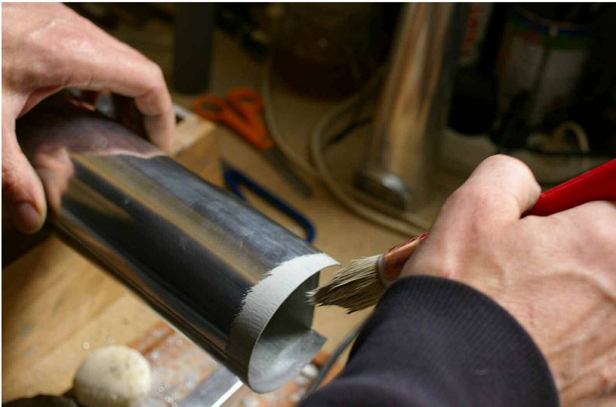
PEINTURE ISOLANTE INTÉRIEURE AVANT SOUDURE
